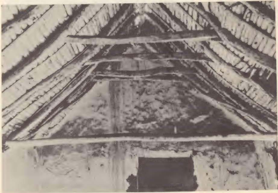
constructie van een tortodak
